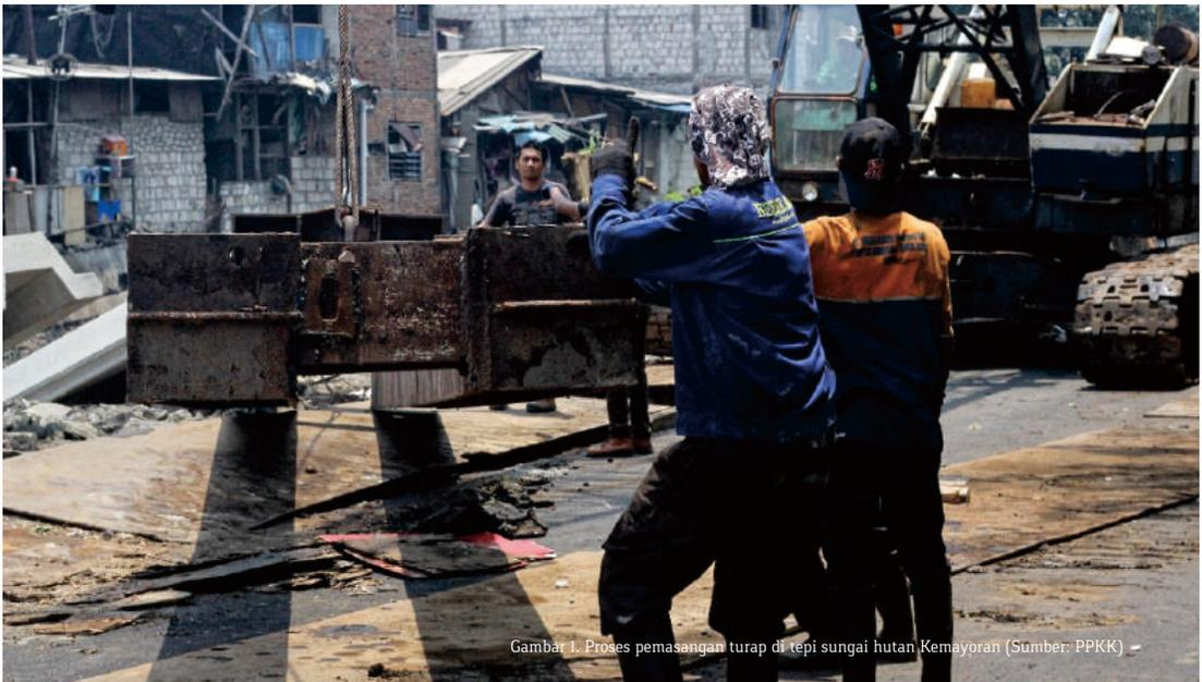
Gambar 1. Proses pemasangan turap di tepi sungai hutan Kemayoran (Sumber: PPKK)
